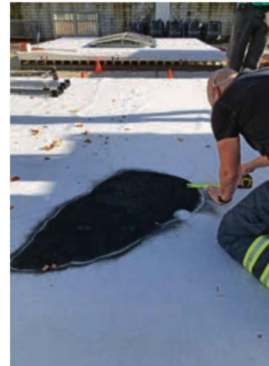
▲ Grootschalige brandtest met glas-glas zonnepanelen op EPS-dak: opmeten van de minimale schade aan het dak. Er is geen warmteontwikkeling onder het dak waargenomen.
