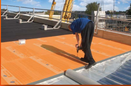
plat dak isolatie
