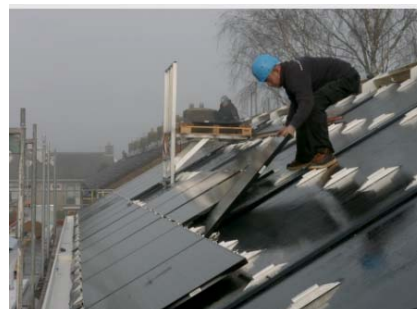
Systeem 3: Toepassing van plat dak dakbedekking op het hellende dak met speciale beugels
