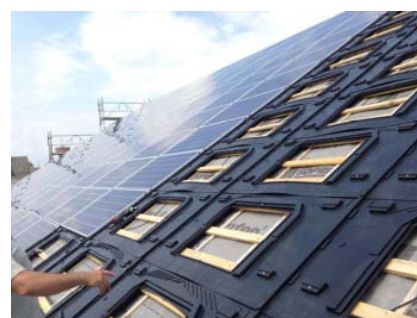
Systeem 2a: Zonnepanelen i.c.m. waterkerende kunststof bakken
